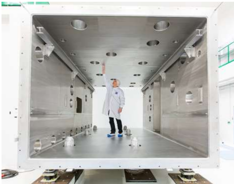
Le premier élément en place sur ses plots, avec l'échelle humaine JMB
