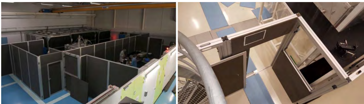
A gauche : Vue de l'implantation des cloisons modulaires à l'époque dans l'installation LUIRE. A droite : Vue de la mise en place des cloisons modulaires dans la zone LPA de l'installation Apollon.
