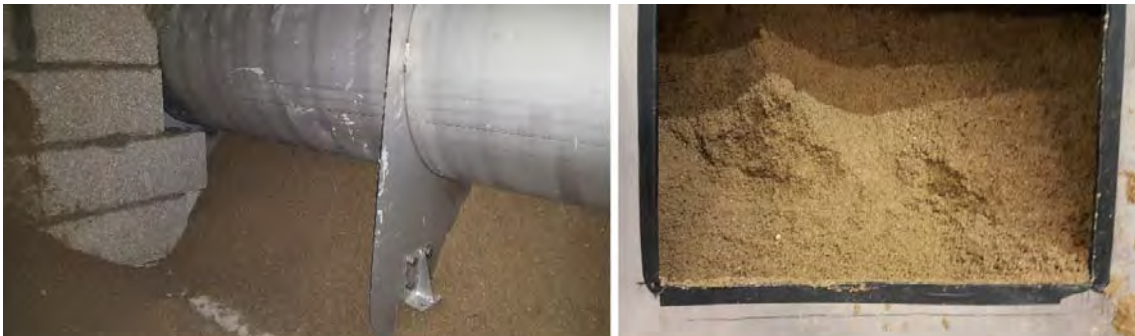
Vue de l'intérieur de la meurtrière en cours de remplissage de sable.
