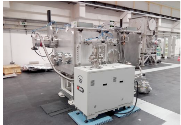
Enceinte LFI2 de mise sous vide dans LFA
