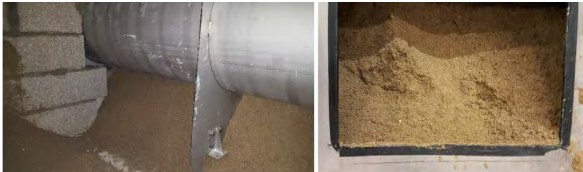
Vue de l'intérieur de la meurtrière en cour de remplissage de sable.
