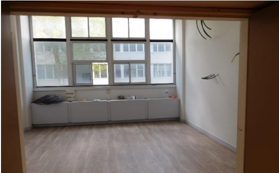
1ere pièce en cours de travaux
